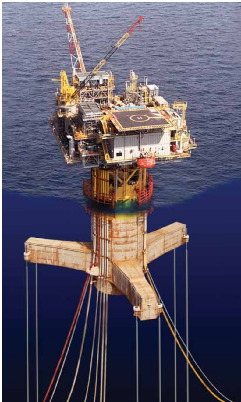
De Typhoon SeaStar® faciliteit voor Chevron in de Golf van Mexico. De TLP draagt de installatie om de olie te verwerken, die via op de zeebodem afgewerkte putten wordt gewonnen.
