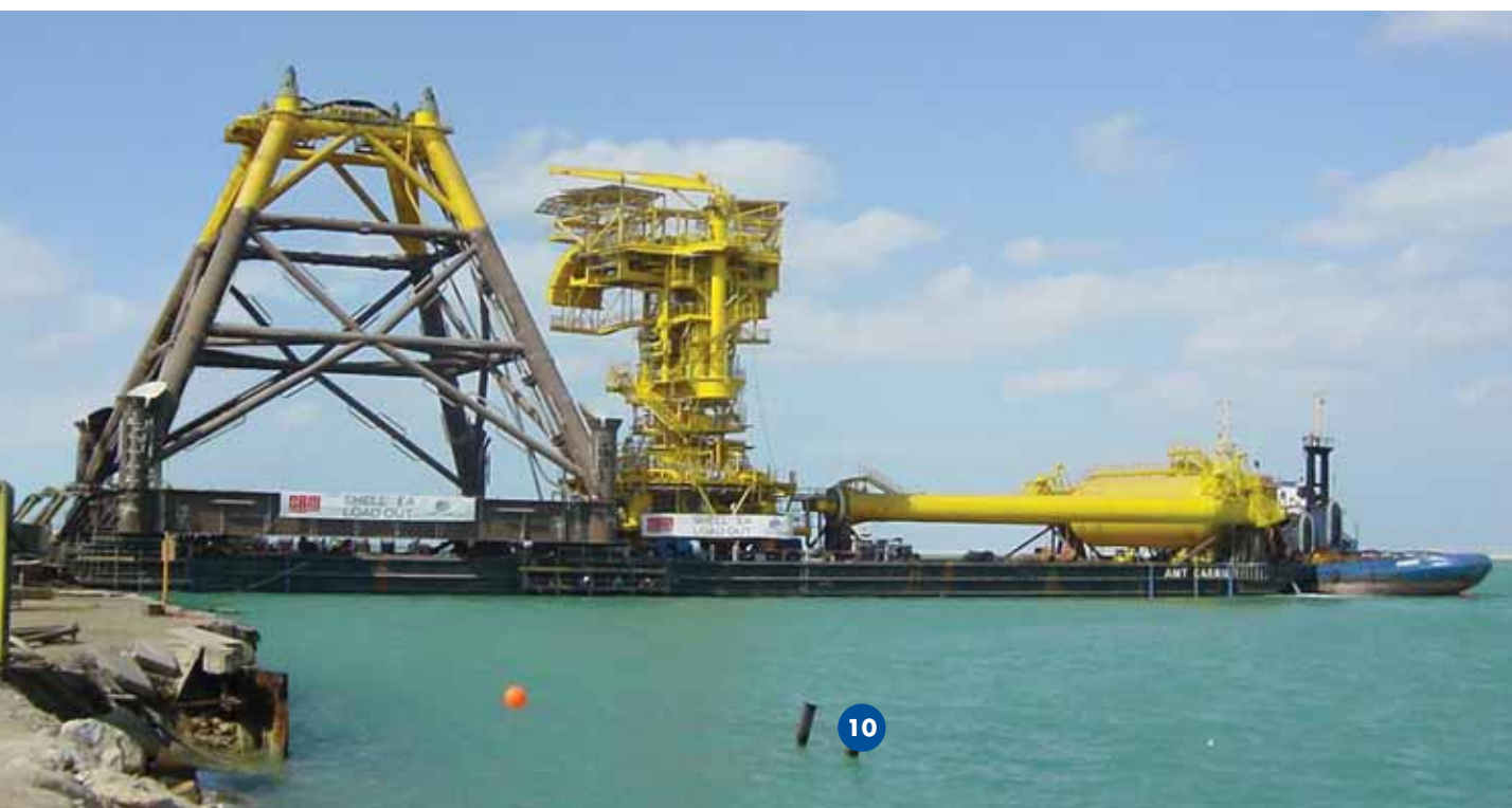
Alle onderdelen van het Shell EA FPSO afmeersysteem op het zware ladingsschip.
