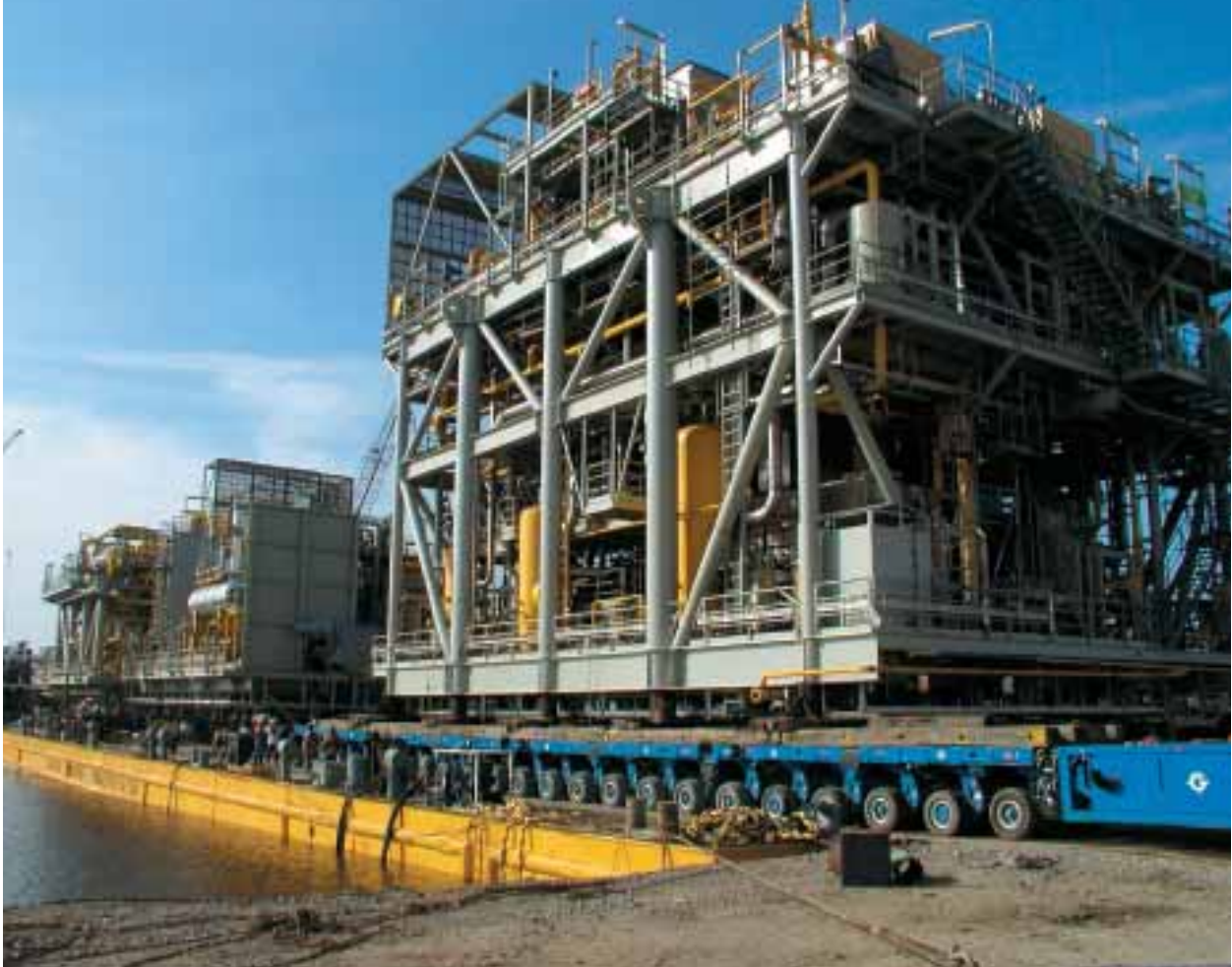
Het transport vanaf de bouwwerf van de belangrijkste modules voor phase 2A van de Kuito FPSO, voor buitengaatse installatie op de FPSO.
