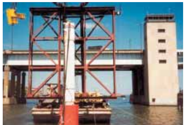
De S-500 Hydrohammer, gebruikt bij de Woodrow Wilson Bridge, VS.
