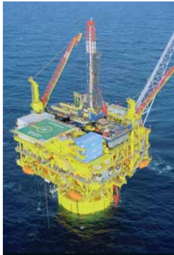
De éénkoloms-TLP met putafwerking boven water voor Total's Matterhorn-veld in de Golf van Mexico
