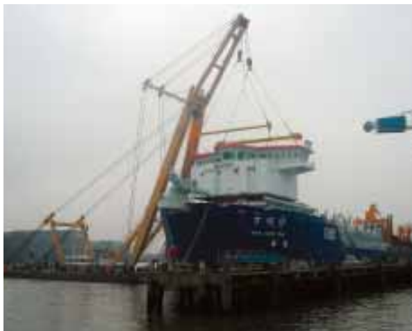
Installatie van het dekhuis van de 10000 m 3 sleeppopperzuiger 'Wan Qing Sha' voor CHEC – Guangzhou Waterway Bureau, China
