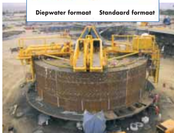
Kizomba A diepwater CALM-boei op de bouwwerf in Lobito voor blok 15, Angola
